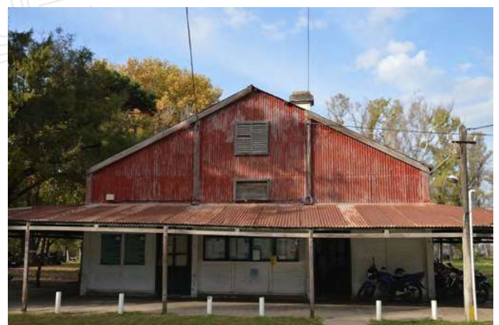
Vista frontal del edificio donde funcionó originalmente la Biblioteca de la EEMAC.
