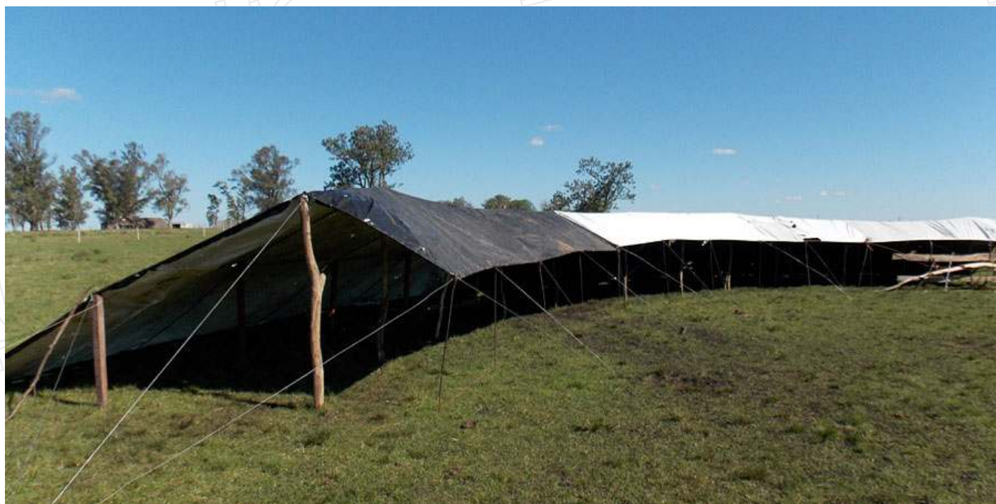
Figura 2. Obsérvese detalle de construcción de refugios de abrigo modelo "Tico" con nylon de silo, varilla de hierro, madera y alambre.
