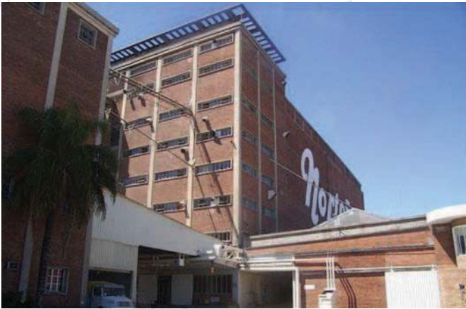
Planta CYMPAY S.A. (Ambev). Vista de las instalaciones de M1
