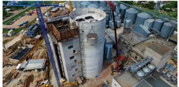
Planta MOSA. Detalle de la construcción de la torre de M2
