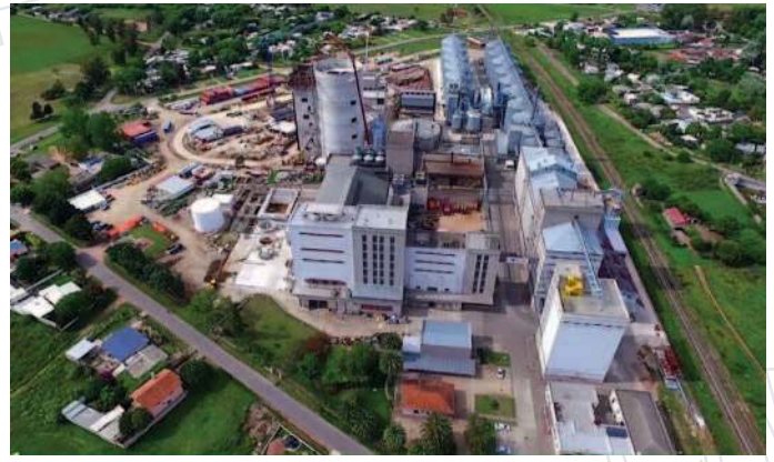
Planta MOSA. Vista aérea de las instalaciones
