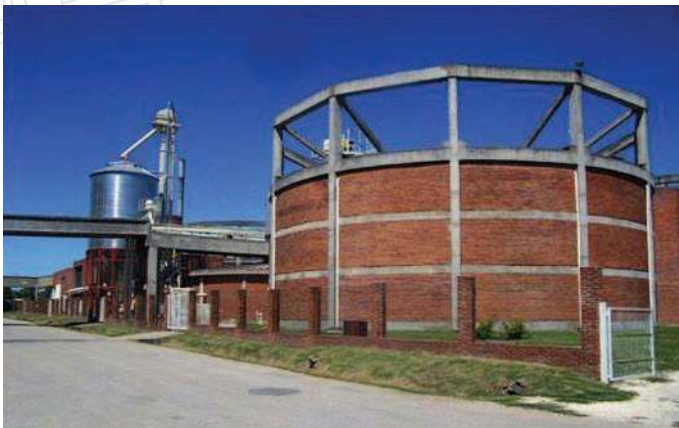
Planta CYMPAY S.A. (Ambev). Vista de las instalaciones de M2
