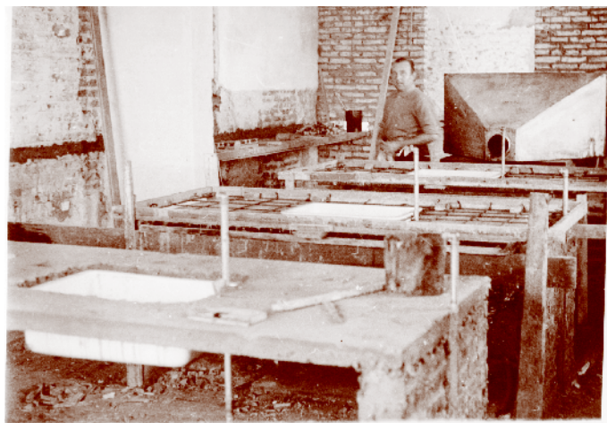
Construcción de los Laboratorios de la Estación Experimental Paysandú
