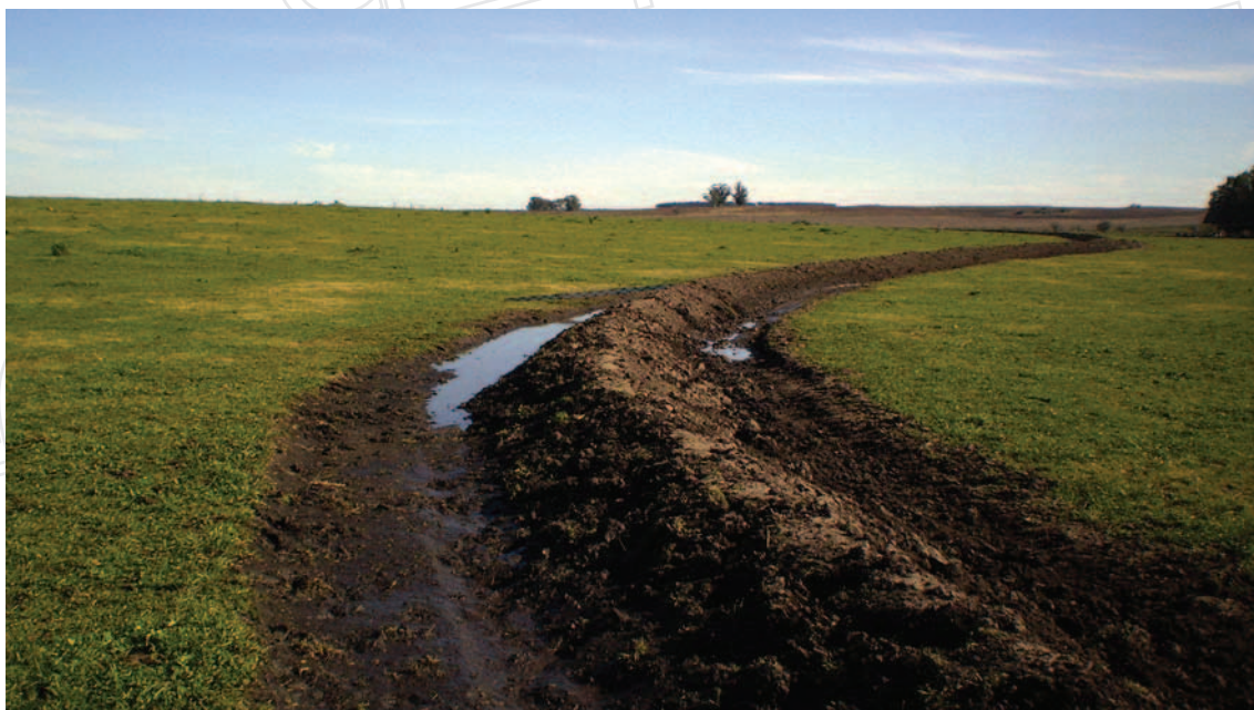
Figura 1: Canal de ladera construido con arado de cuatro discos y terminado con pala de cola de tres puntos, para un sistema de riego. También puede considerarse un canal de drenaje, o sea una terraza de drenaje no cultivable.
